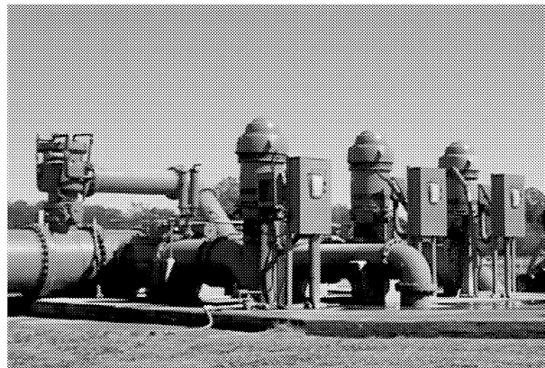
CENTRIFUGAL EFFLUENT PUMPS
